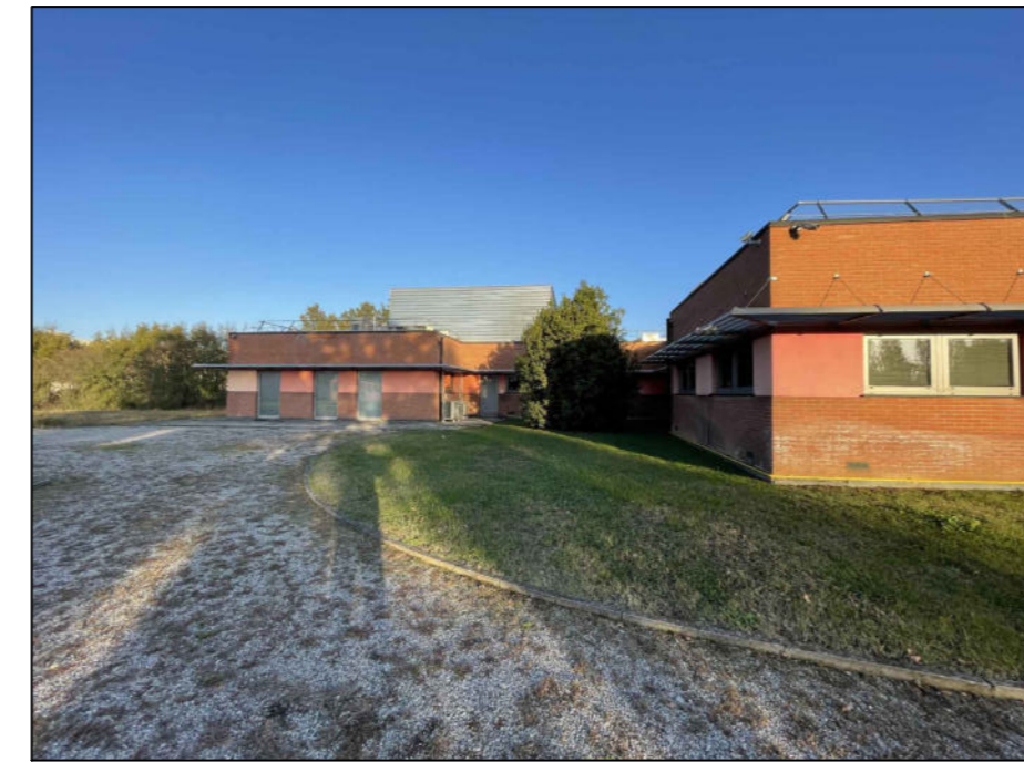
FOTO 02 - AREA ESTERNA AMPLIAMENTO
