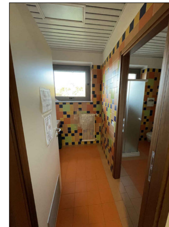
FOTO 11 - BAGNO AREA DI RISTRUTTURAZIONE
