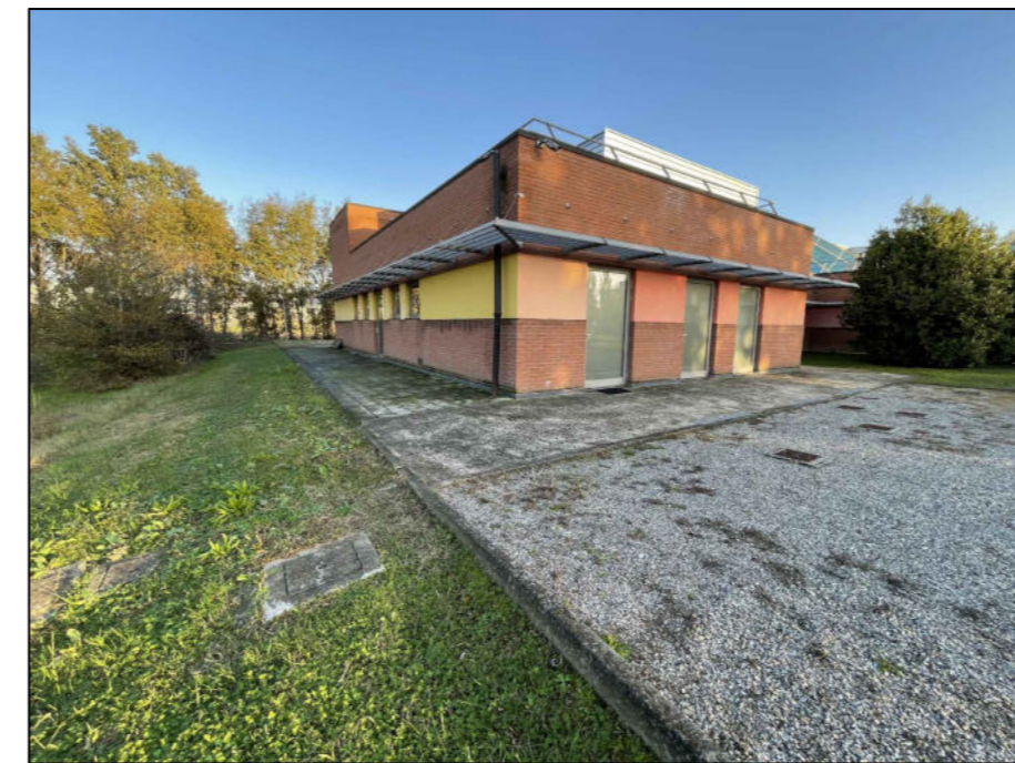
FOTO 08 - ESTERNI AREA DI RISTRUTTURAZIONE
