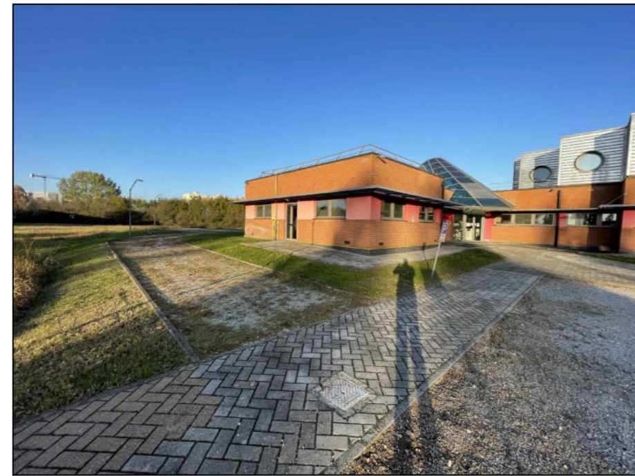
FOTO 01 - INGRESSO EDIFICIO ESISTENTE
