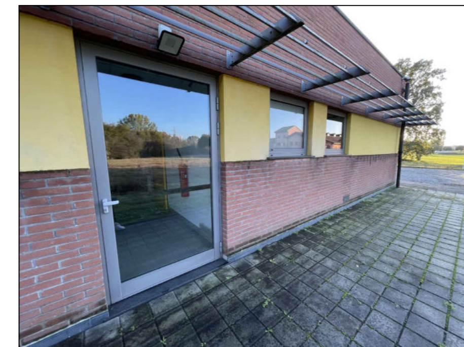
FOTO 18 - ESTERNI AREA DI RISTRUTTURAZIONE
