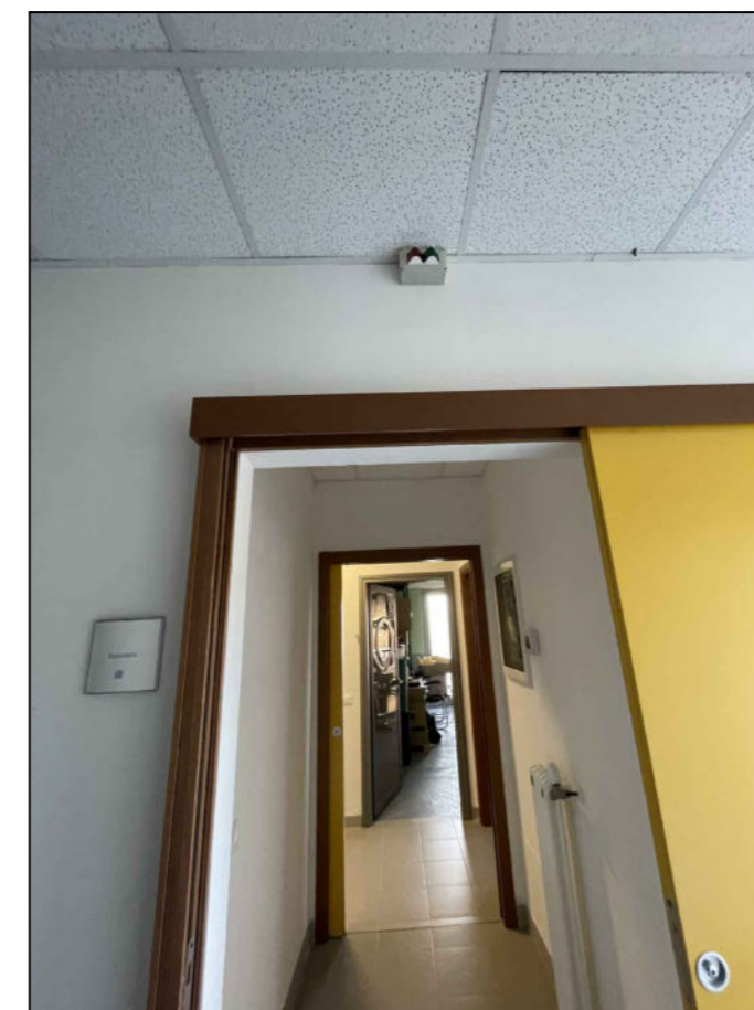
FOTO 10 - PORTA DI ACCESSO
