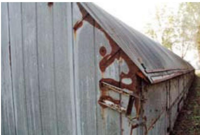
*Figura 7. Struttura di allevamento arrugginita con crepe e fessure*
