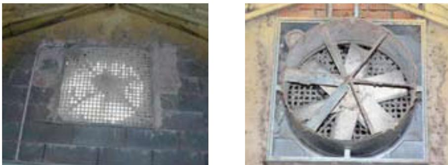
*Figura 18. Polvere e pelo sulla parte interna (a sinistra) ed esterna (a destra) dell'impianto di ventilazione influiscono negativamente sulla qualità e quantità degli scambi gassosi*
